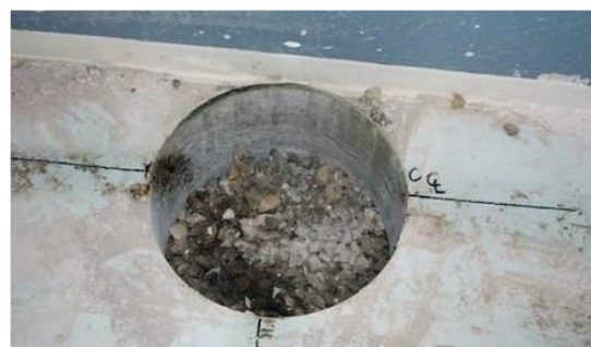
Grundläggning inne i Flygvapenmuséet. Grundtuben ® slås ner genom befintlig bottenplatta utan att grävning behövs.
