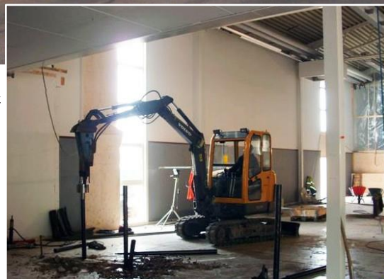
Grundläggning och grundförstärkning av befintlig byggnad till Toyota (BT) i Mjölby.
